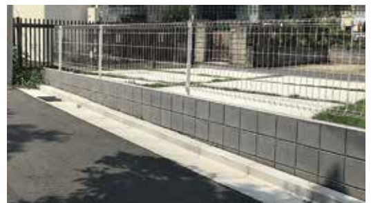
〔新設フェンス〕
