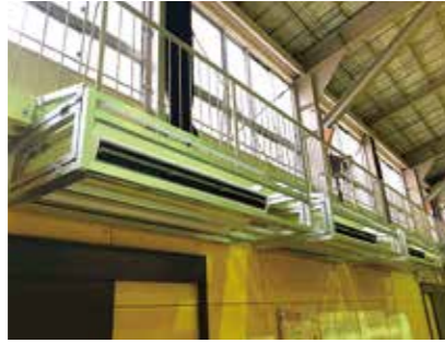
日吉南小学校体育館のエアコン設置
